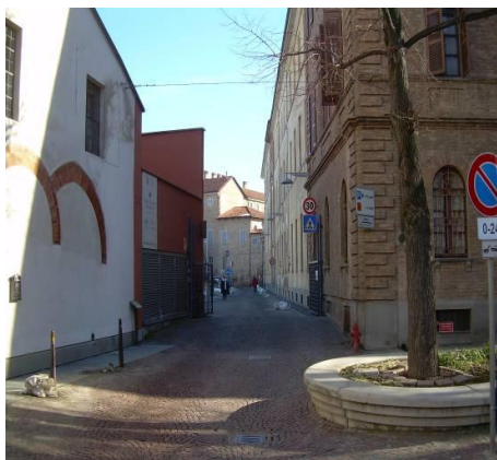
Ingresso della struttura da Piazza V. Veneto
