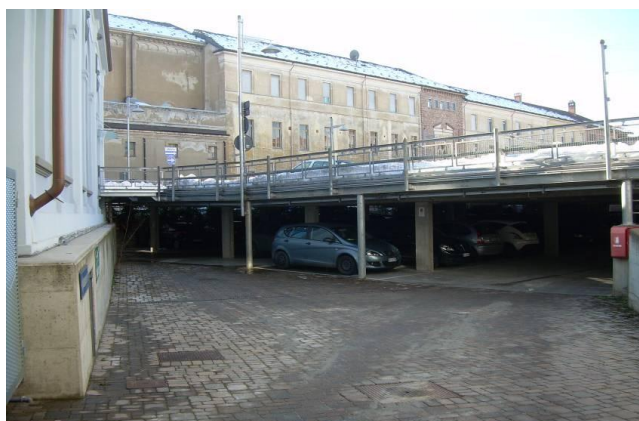
Vista parcheggio sottolivello riservato ai dipendenti ed alle auto aziendali
