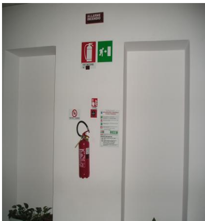
Vista posizionamento estintori, pulsanti di allarme incendio e cartellonistica
