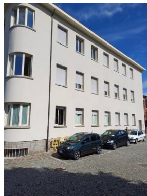
parcheggio antistante l'ingresso alla struttura
