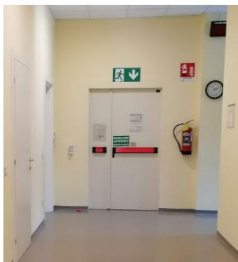
Vista uscita di sicurezza con estintore
