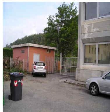
Ingresso carraio laterale
