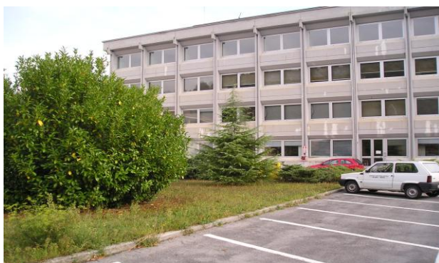
parcheggio antistante l'ingresso alla struttura
