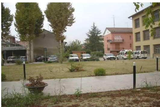
giardino antistante l'ingresso della struttura su Via San Martino
