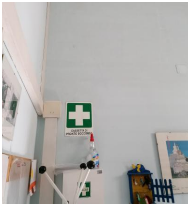
Cassetta di primo soccorso c/o locale accoglienza Centro Diurno - piano terreno
