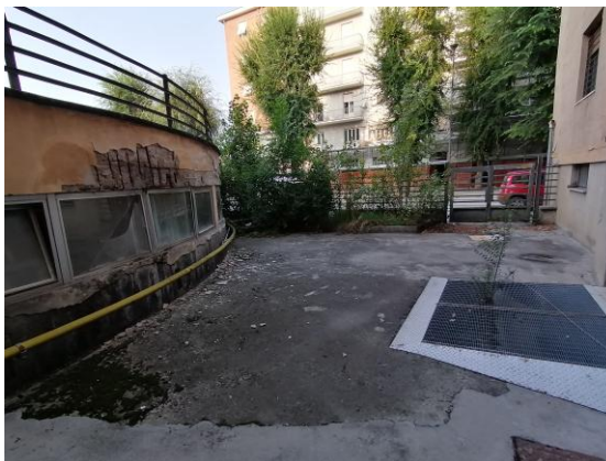
cortiletto adiacente ex accesso camera calda DEA
