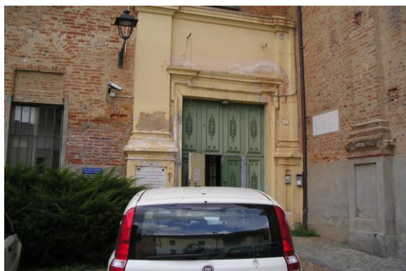
Vista ingresso - Largo Dott. Vanni
