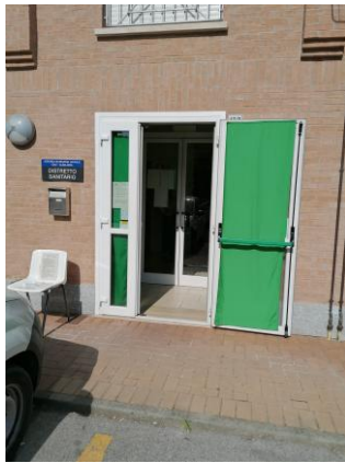
Vista ingresso della struttura
