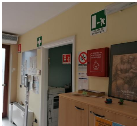
Cassetta contenente il registro antincendio (sala d'attesa)
