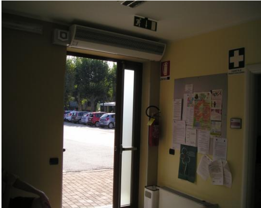
Uscita di sicurezza
