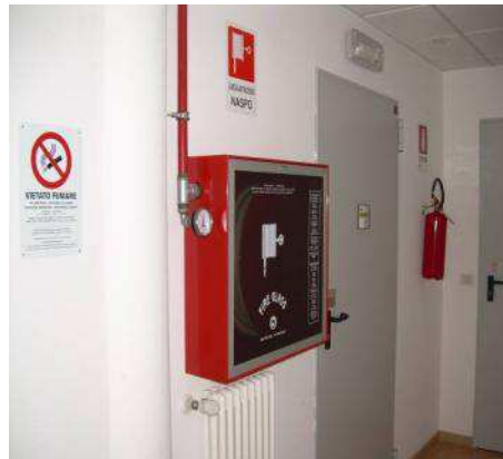
estintore a CO2, estintore a polvere e idrante installati a Canale
