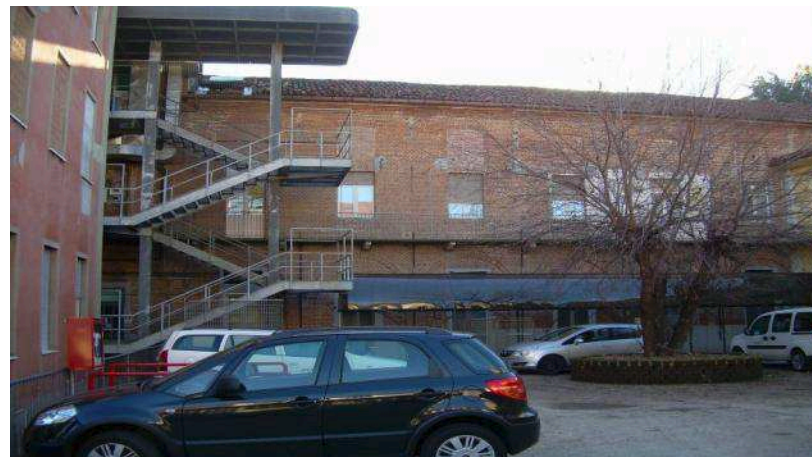
scala antincendio cortile interno area ex lavanderia Bra
