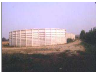
Fig. 5 - Vasca di stoccaggio realizzata con elementi prefabbricati
