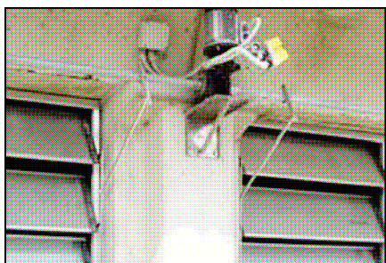
Fig. 52 - finestre con apertura comandata da centralina automatica
