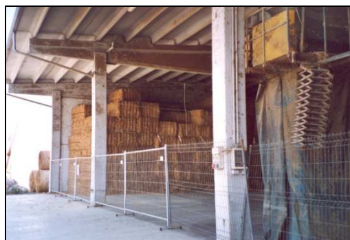
Fig. 20 Delimitazione /interdizione dell'accesso all'area pericolosa
