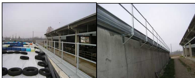
Fig. 31 - protezione anticaduta delle pareti di contenimento
