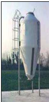
Fig. 26 - Silo verticale realizzato in vetroresina
