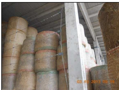
Fig. 19 Sistema di contenimento con cavi
