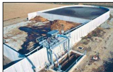
Fig. 6 – Platea di stoccaggio dei reflui solidi realizzata vicino alla vasca di stoccaggio dei reflui liquidi
